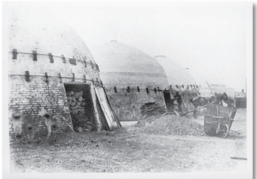
Empilement de bois dans un four de type beehive. Les fours sont percés de petits orifices que les charbonniers obstruent au besoin pour limiter l'apport d'oxygène. Les kilns sur le site des Forges Radnor, vers 1900. (Fonds G. Malchelosse, Université Laval)
